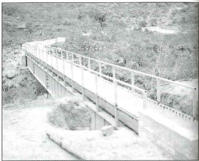
Acueducto sobre Quebrada Cóndorhuayco
